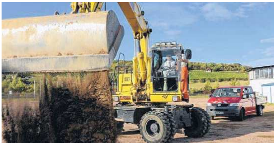
Ließ es sich nicht nehmen, einmal selbst Bagger zu fahren: der Innenminister. Zudem will er zur Platzzeröffnung in kurzen Hosen wiederkommen.
